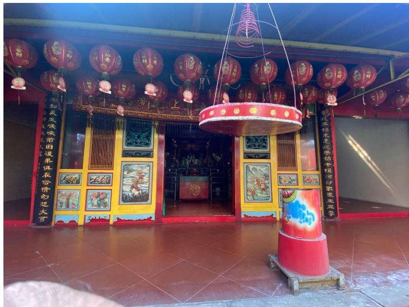
Gambar 4.5.8 Bangunan pertama pada Vihara pada tahun 1595 ( Sumber: Dokumentasi 2023 )
