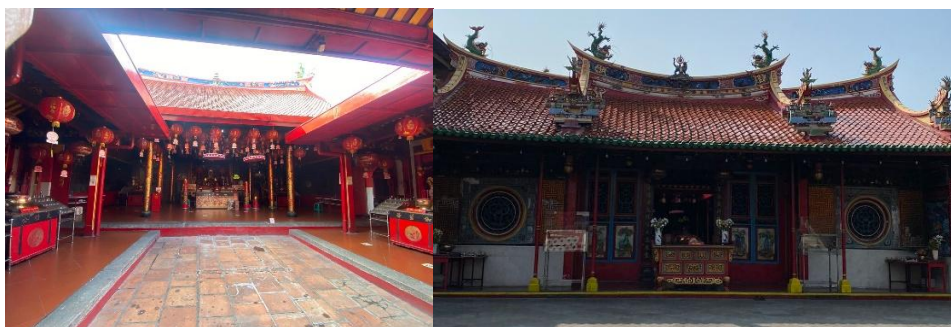
Gambar 4.5.2 Bangunan utama Vihara ( Sumber: Dokumentasi, 2023 )
